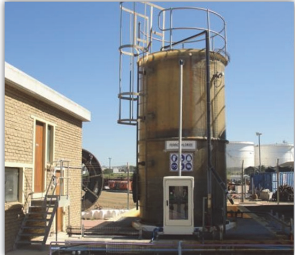
1 of 2 CIP tanks – 1 per 3 RO membrane units
