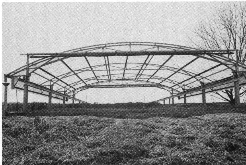
'n Reënskerm om die effek van reënval op 'n proefperseel uit te skakel waar spesifieke besproeiingsbehandelings ondersoek word.
