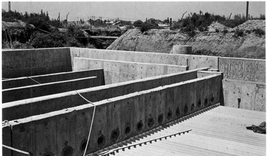
Outomatiese terugwassandfilters (onder konstruksie). Voor is die plastiese partisies vir die individuele selle op die vloer en die gate waardeur rouwater na die filter gevoer word.
