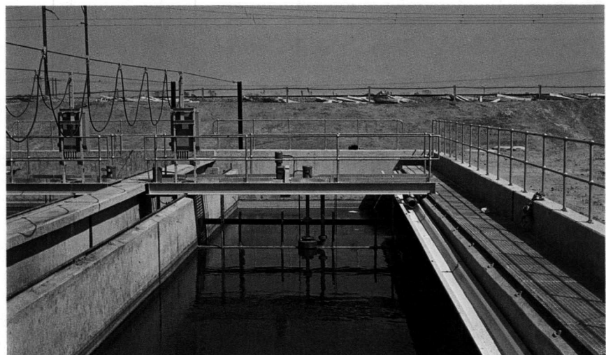
Voltooide sandfilters en bewegende brug, volledig met terugwaspompe. (Sien sandfiltrasie).
