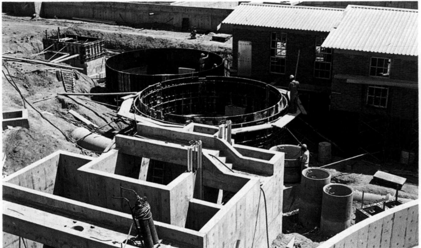
Die westelike aansig van die chemiese huis met kitsvermenging, flokkulasiekamers en opgeloste lugflottasie-eenheid vir die indigting van die aktiefslyk.
