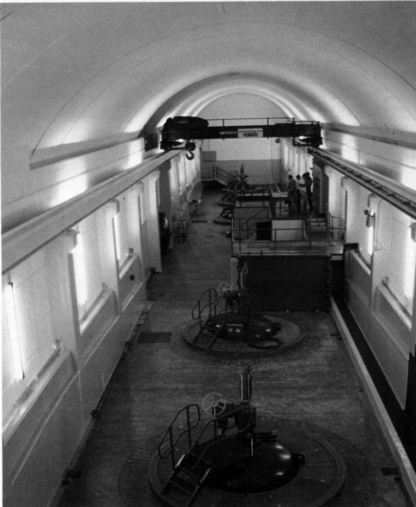
'n Ondergrondse beheerkamer by Teebus waar die water van die tunnel na 82 km weer aan die daglig blootgelê word.
