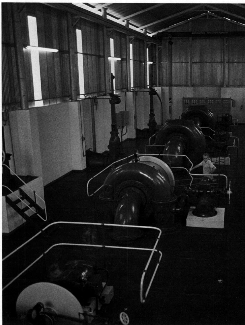
'n Blik op die vyf turbine-eenhede wat op die Lomatilandgoed gebruik word om meer as 1 020 kVA vir besproeiingsdoeleindes op te wek.
