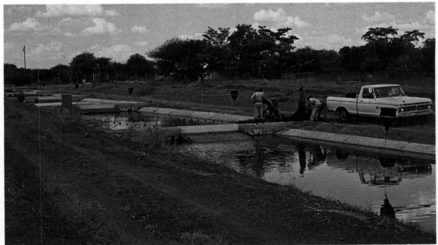
Die klaterkanaal-visproduksiestelsel wat by die Laeveldse Visserynavorsingstasie te Marble Hall gebou is. Die aanleg bestaan wesentlik uit 'n sewevoudige kanaal-damsisteem waar die water van die een dam na die ander oorvloei.
