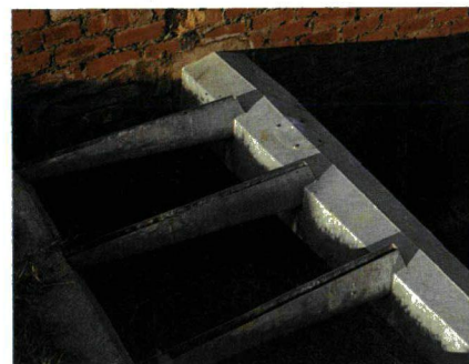
Die verdeler verwyder 'n vyf persent monster van die afloopwater.
